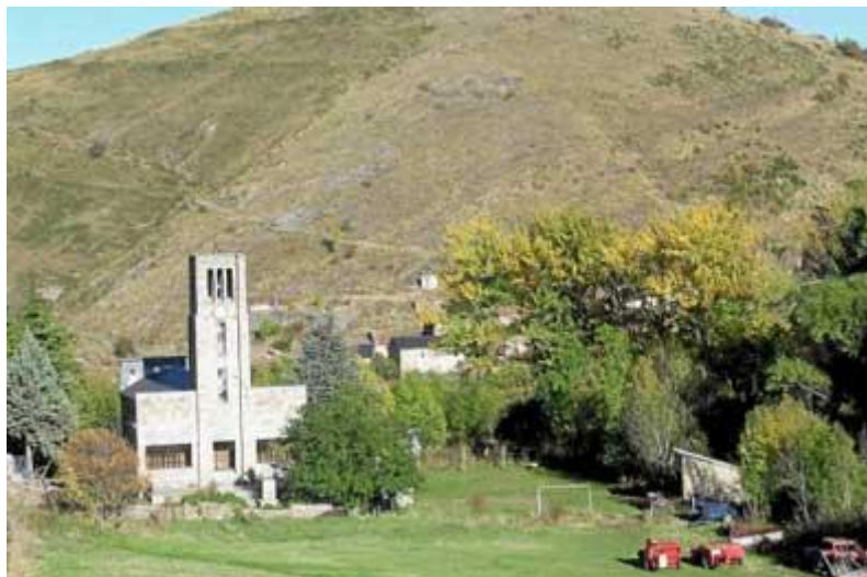
Iglesia moderna de San Pelayo, construida en 1964 en la vega de Abelgas.
